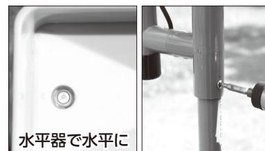
水平調整後、パイプ下にあるネジ穴にネジ（短）を取り付け、本体支柱に本体を固定します。（図C）
