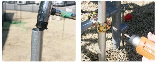
※ハンマーでパイプを地面に打ち込みます ※ネジをきつく締めて固定します
