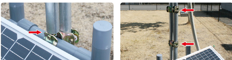
※9の固定クランプ(金具の上)に乗せます
