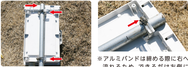
※通信ボックス頭にメッキパイプを揃えて
