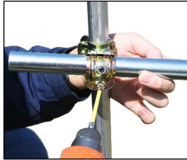
イモネジ付き自在クランプのボルトを固定します。
